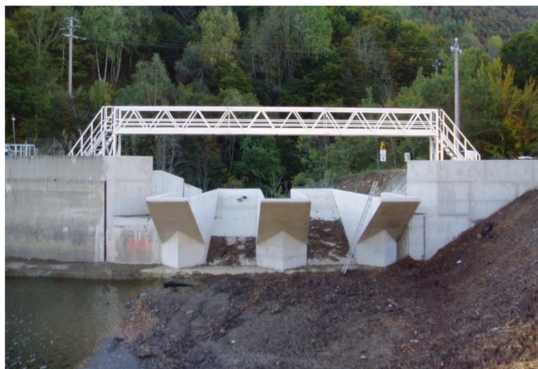
Fig. 4 Déversoir en touches de piano (P.K.Weir) réalisé en 2006 au Barrage GOULOURS (France)
