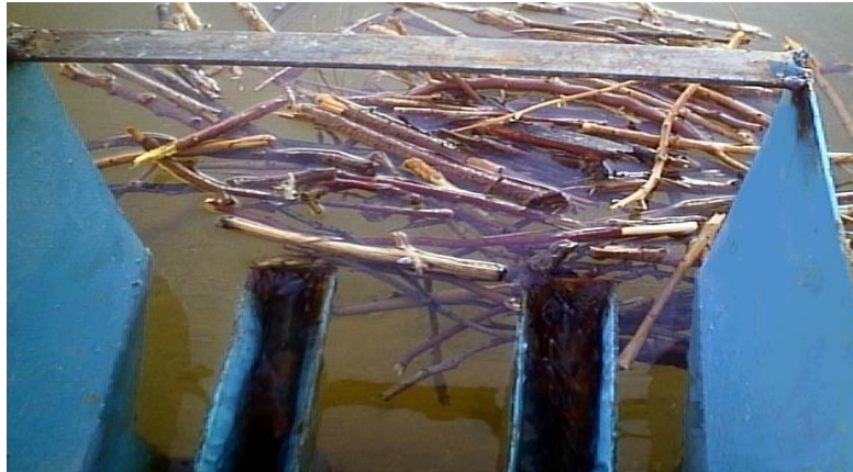
Fig. 13 Fonctionnement du P.K.Weir avec encombrement de l'entrée par des corps flottants
